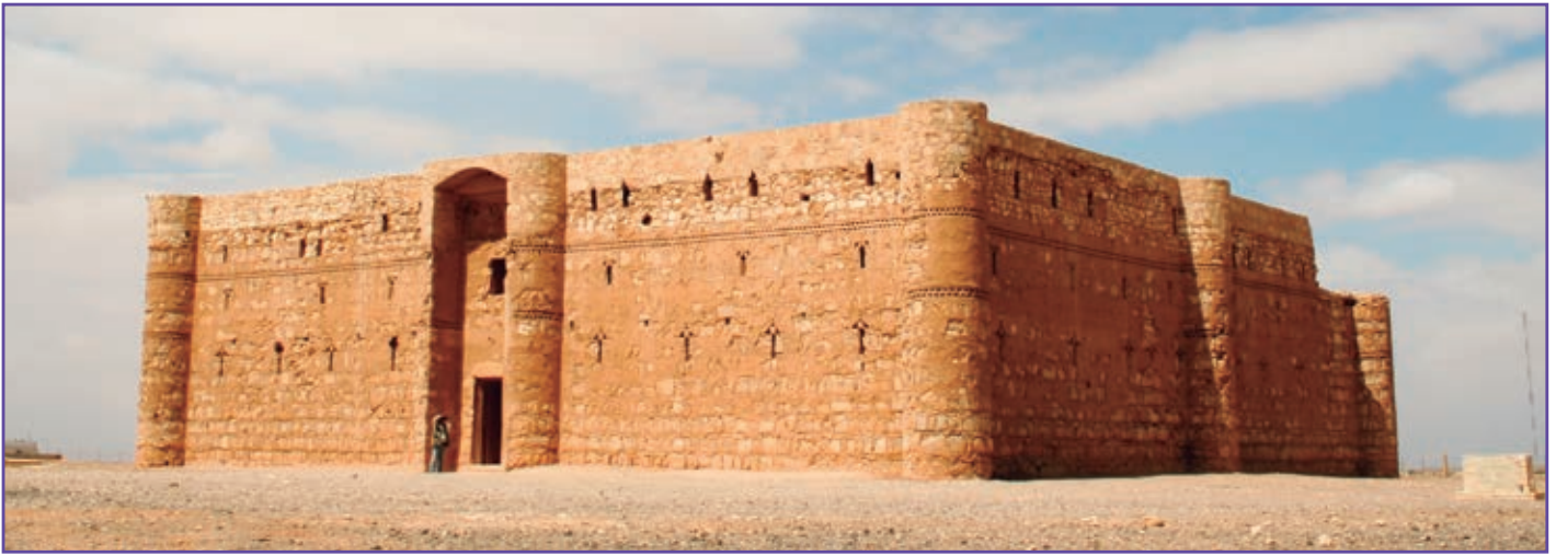
QASR KHARANA, CON SU IMPONENTE ESTRUCTURA DE MUROS GRUESOS
